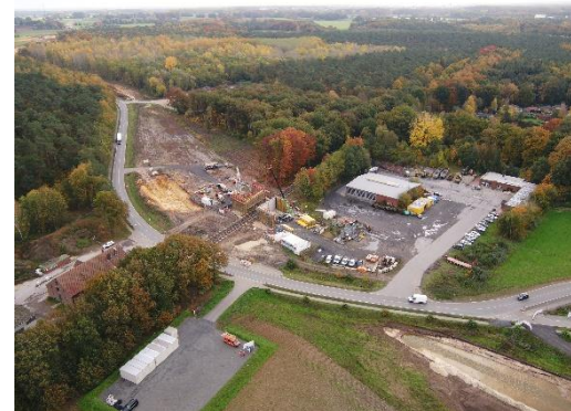
Bautätigkeiten am Bahnübergang der L600, Dülmen-Merfeld
