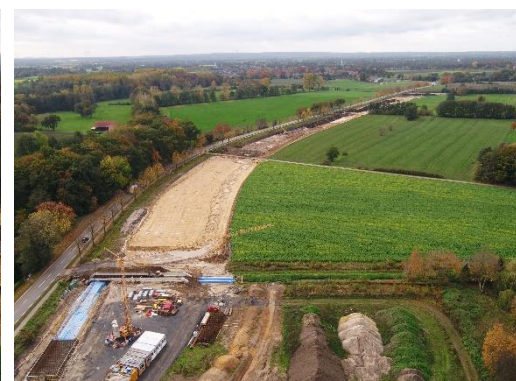
Erdbauarbeiten parallel der Landesstraße 600, Richtung Reken
