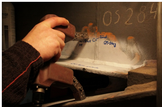
Untersuchung mittels Magnetpulververfahren auf Risse
