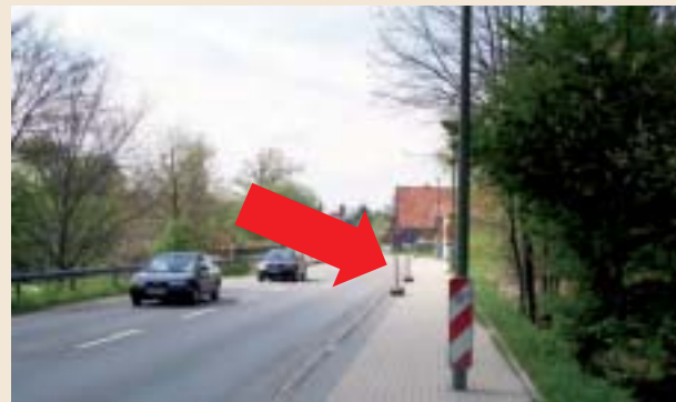
Beleuchtungsmast im Radweg
