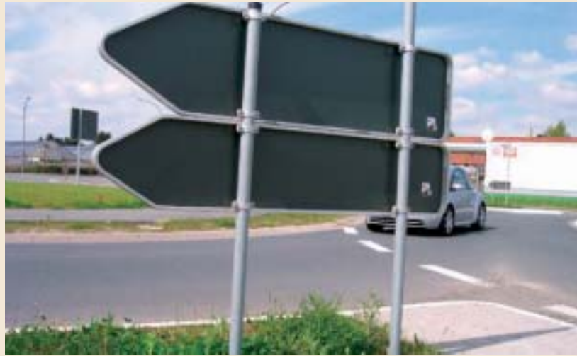
Sichtbehinderung durch Pfeilwegweiser im Kreisverkehr.
