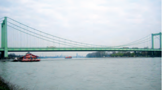
Rheinbrücke Rodenkirchen, Köln
