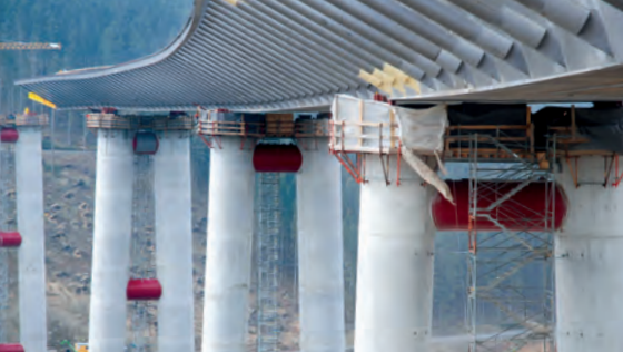
Talbrücke Nuttlar, Nuttlar
