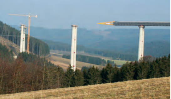
Talbrücke Nuttlar, Nuttlar
