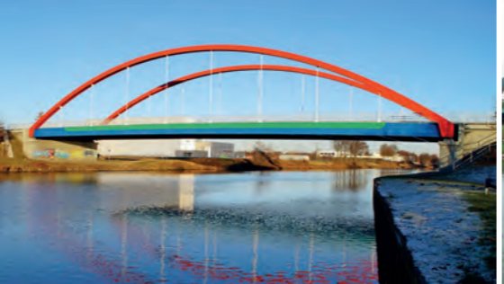
Spellener Brücke Wesel-Datteln-Kanal, Wesel
