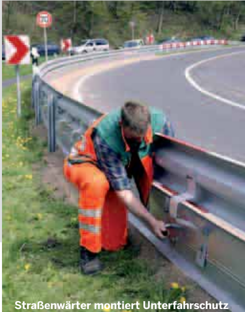
Straßenwärter montiert Unterfahrschutz
